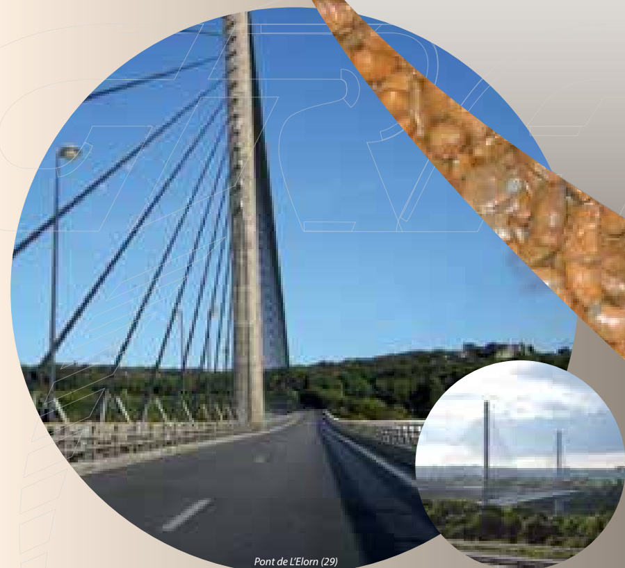
Pont de L'Elorn (29)
