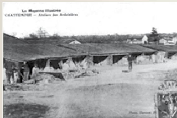
2 - Les ardoisières de Chattemoue début XIX e siècle
