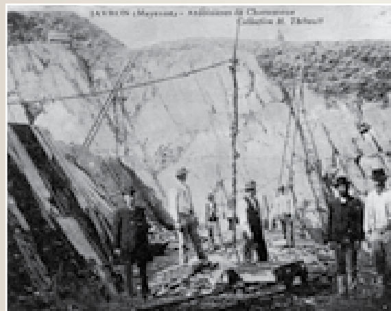
1 - Les ardoisières de Chattemoue début XIX e siècle
