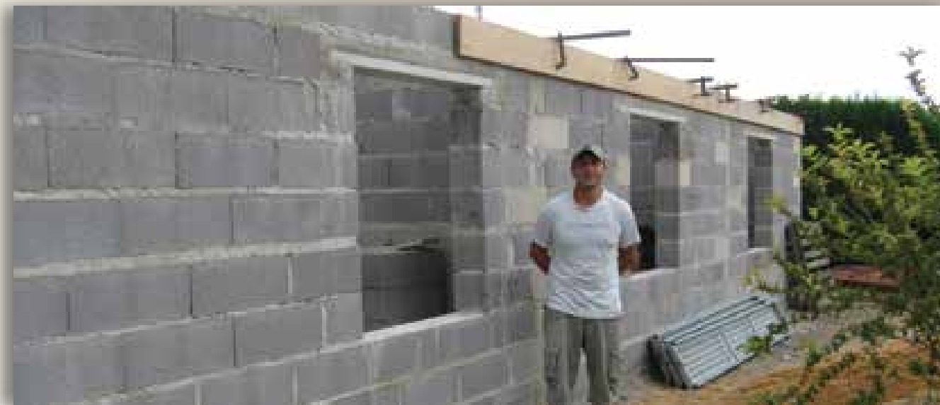
Un chantier en bloc de béton allégés.
